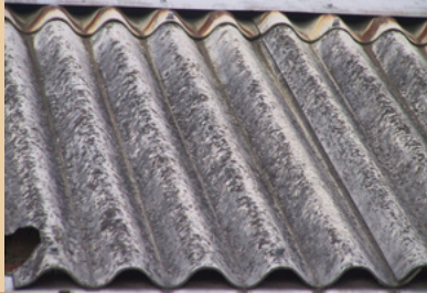
Wellasbestdach
